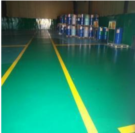
危险废物暂存间
